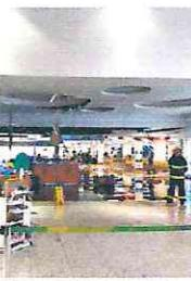
Entrupimento de calha provocou o descolamento de uma placa do forro do teto do aeroporto. Foto: AG. GLOBO
