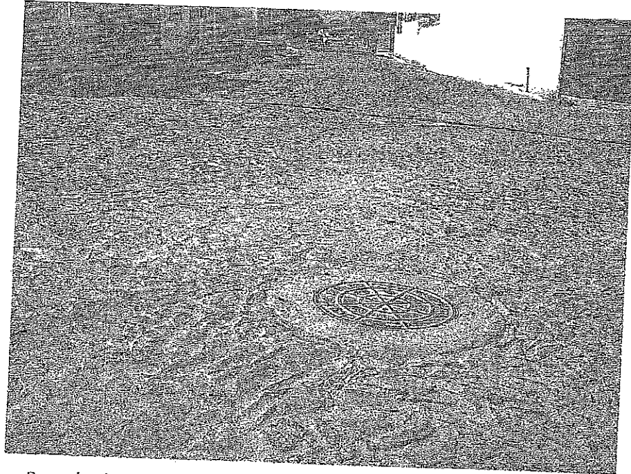
Poço de visita na sede do município onde será lançado os efluentes da localidade de Salgadinho e Mumbaba de Cima
