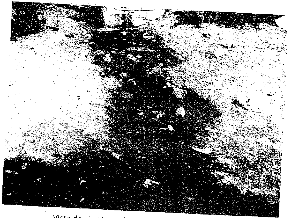
Vista do esgoto a céu aberto na área do projeto
