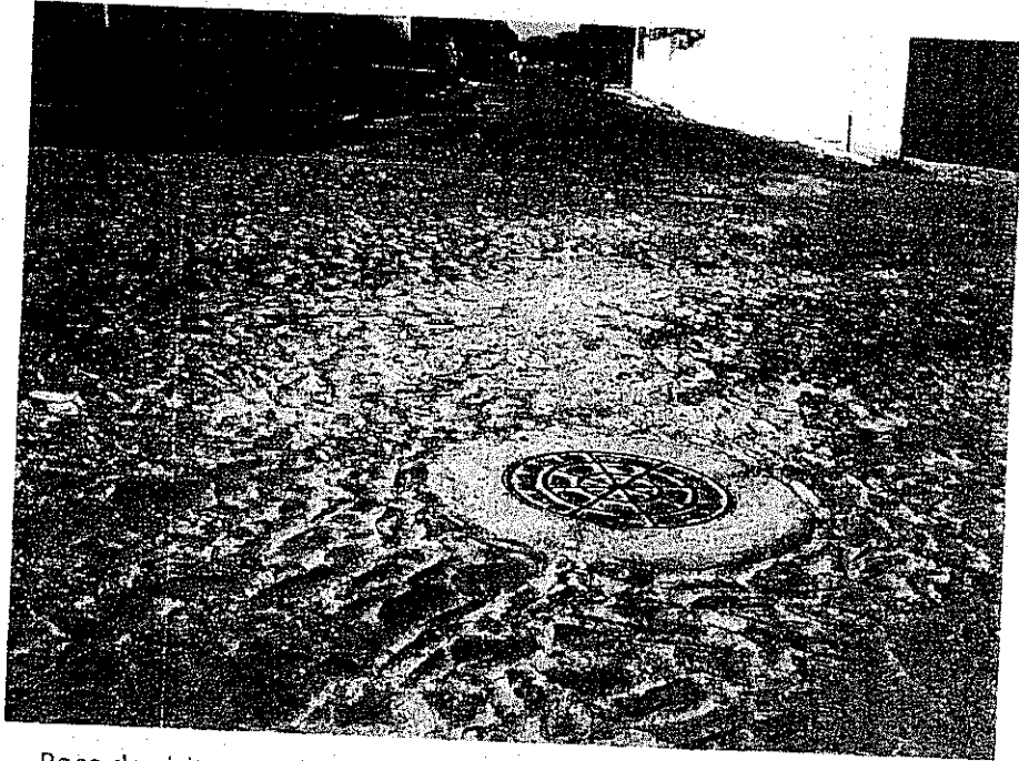
Poço de visita na sede do município onde será lançado os efluentes da localidade de Salgadinho e Mumbaba de Cima
